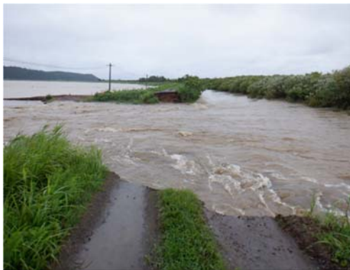
七戸川の堤防決壊と仮堤防復旧（上北支部 石田産業（株）提供）
