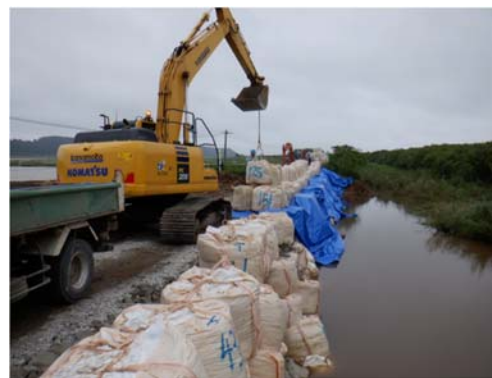
七戸川の堤防決壊と仮堤防復旧（上北支部 石田産業（株）提供）
