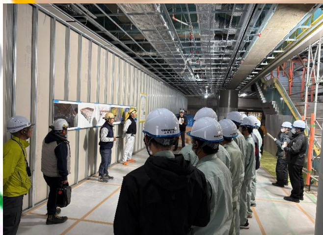
十和田市総合体育センター 長寿命化改修建築工事
