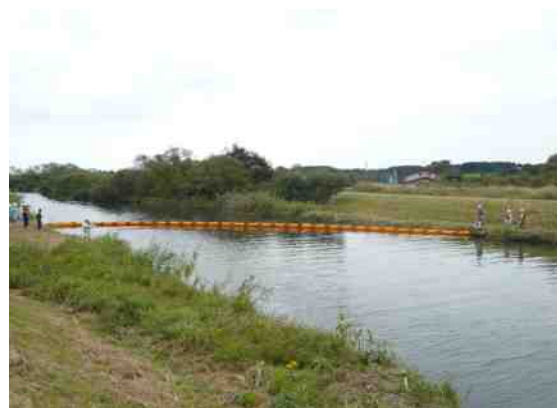
オイルフェンスの設置実演
