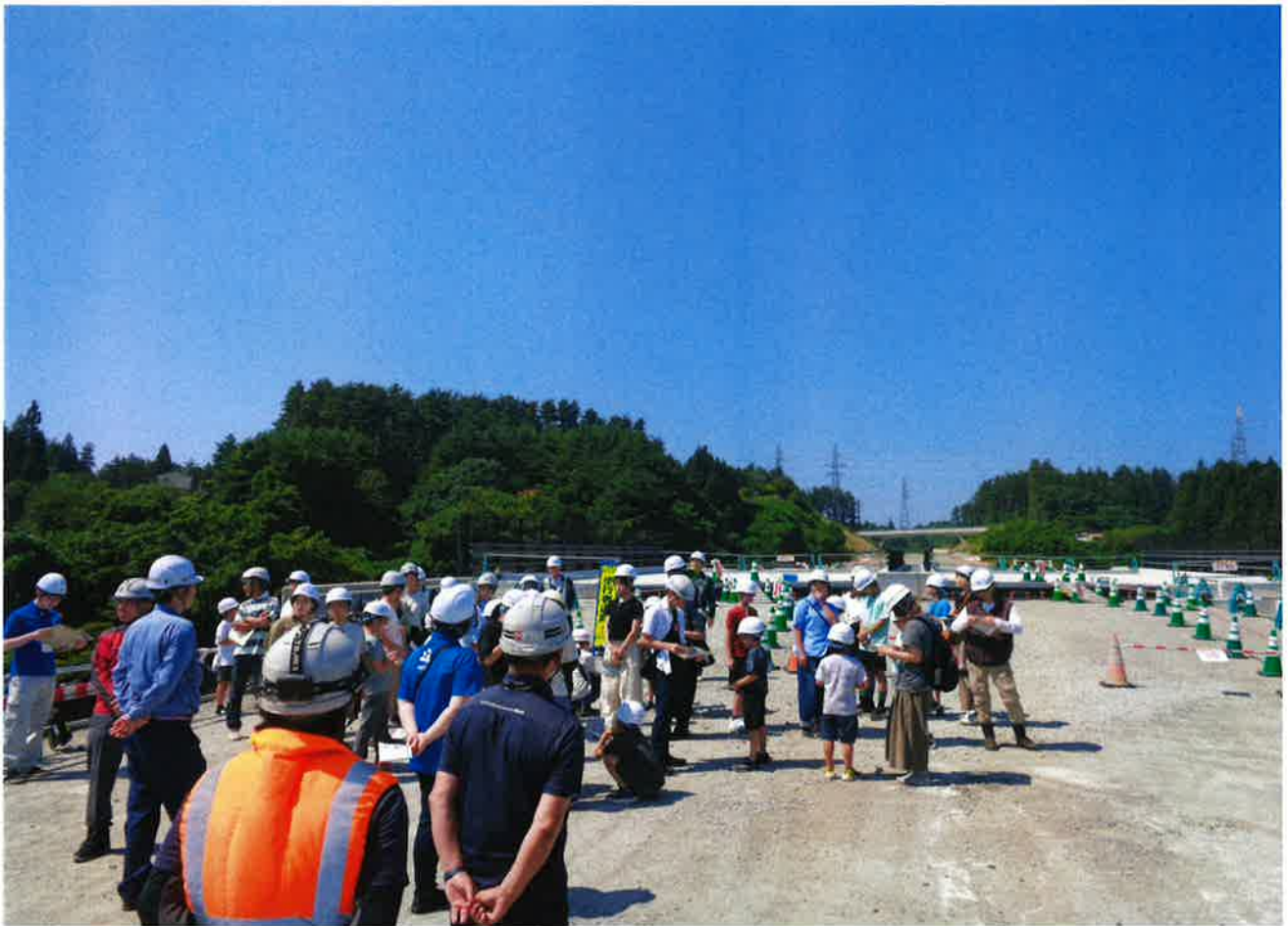
八戸環状線天久岱工区見学の様子です
