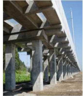
北海道新幹線飛鳥高架橋工事
