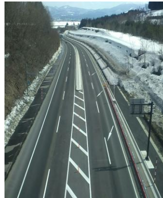
国土交通省発注 安田地区道路改良舗装工事
