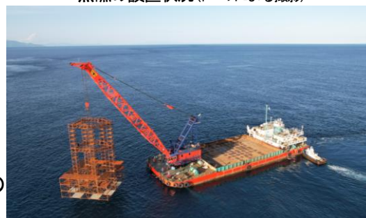
魚礁の設置状況 (ドローンによる撮影)
